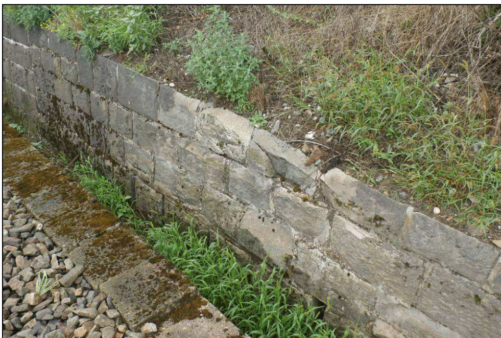
Obr. č. 7 - pohled na porušené kameny lícového zdiva zárubní zdi v km cca 8,020
