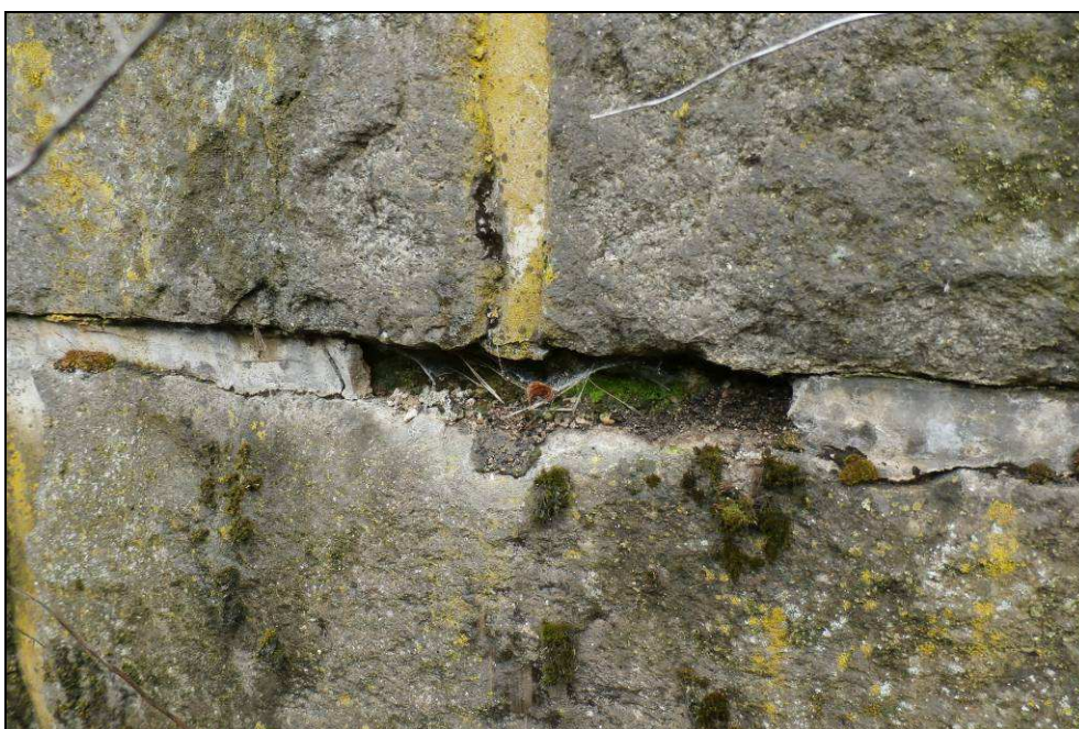
Obr. č. 8 - detail porušeného spárování
